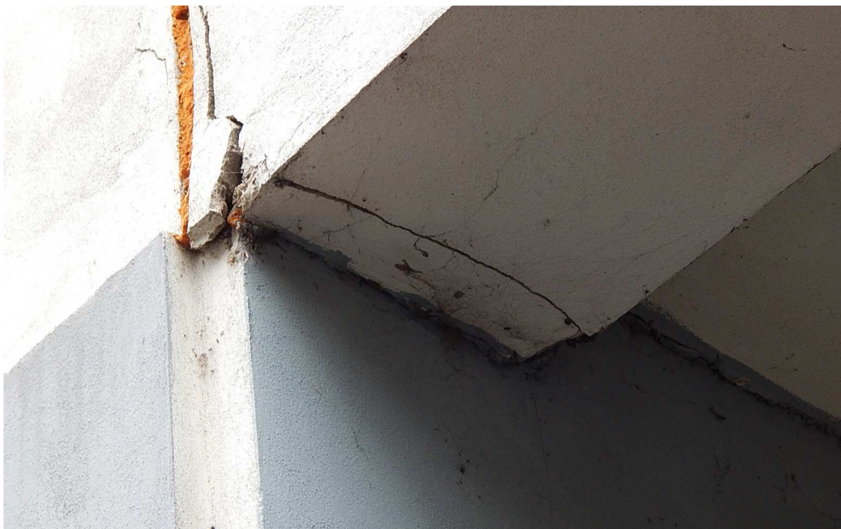
Porucha dilatační spáry – pohled na ostění vstupu z ulice Chelčického
