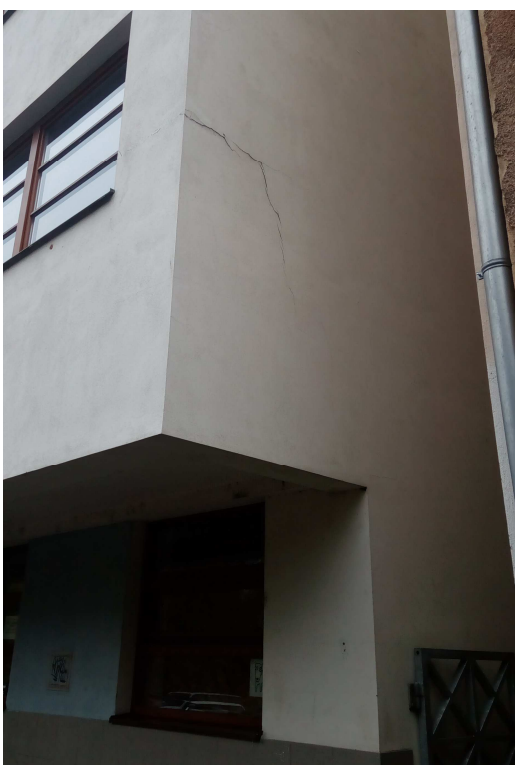
Trhlina ve zdiu přístavby – JV nároží (vliv dotvarování konstrukce)
