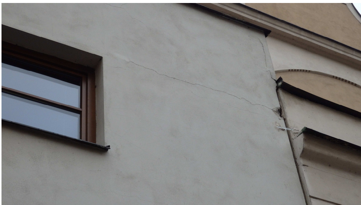
Podélná trhlina v nadpraží přístavby (na styku ztužujícího věnce a zdiva)
