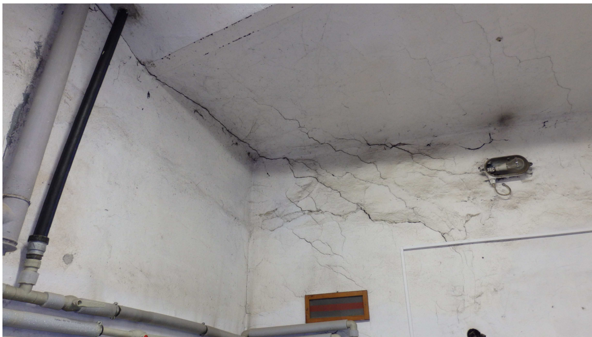
Trhliny ve zdivu suterénních prostor
