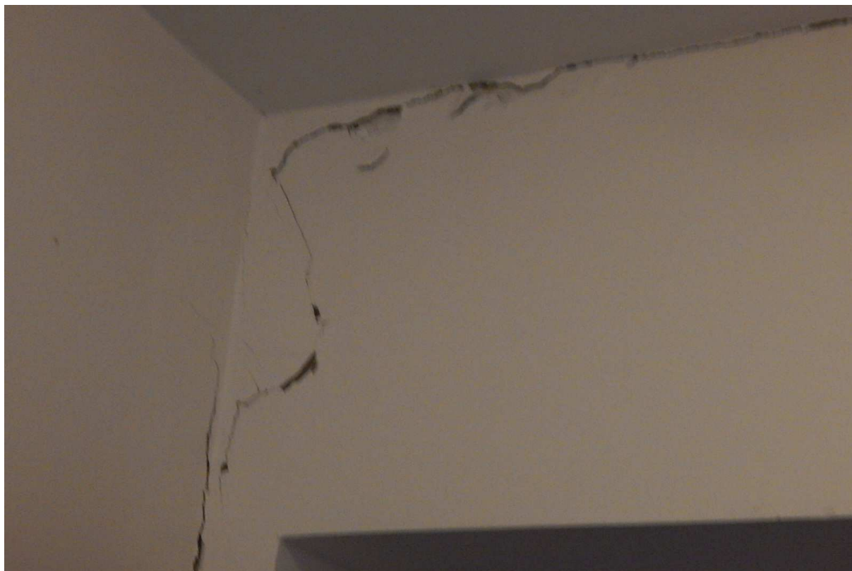
Typická porucha v interiéru na styku konstrukcí přístavby a historické části divadla
