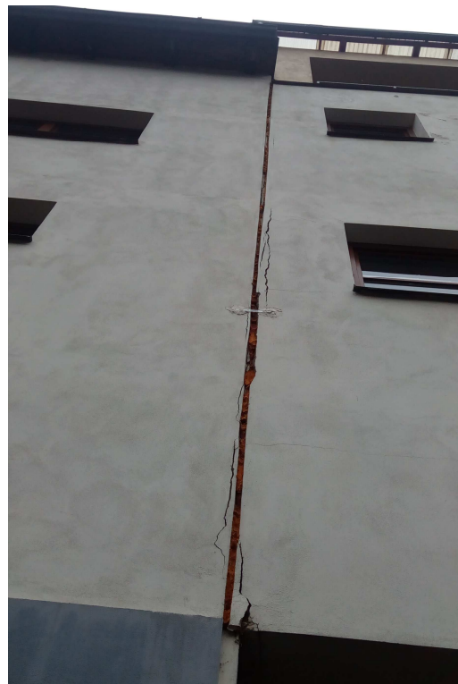
Pohyb dilatační spáry mezi přístavbou a původní historickou částí budovy divadla – prasklé sklíčko
