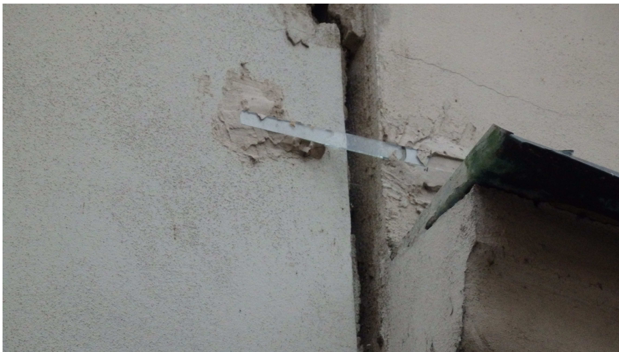
Přetržený kontrolní skleněný pásek mezi přístavbou a historickou budovou divadla
