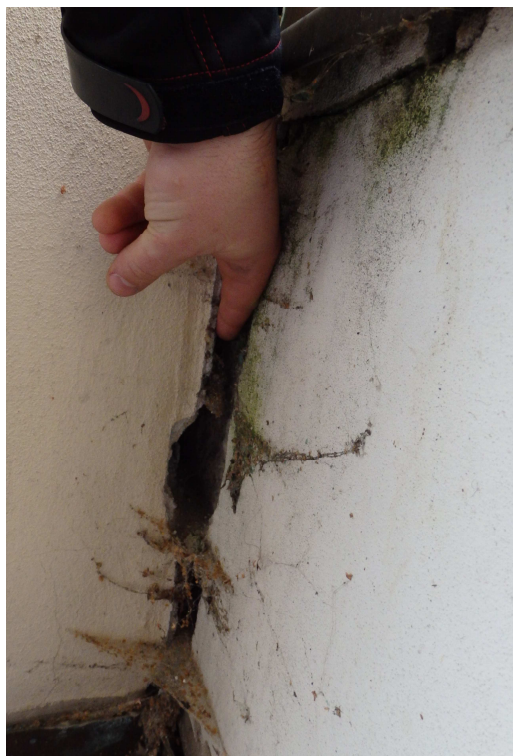
Rozevřená dilatační spára mezi přístavbou a historickou částí budovy divadla
