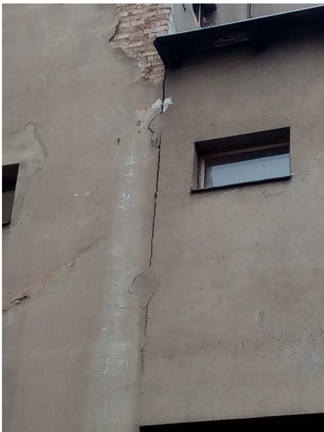
Trhlina – samovolná dilatace přístavku v Chelčického ulici
