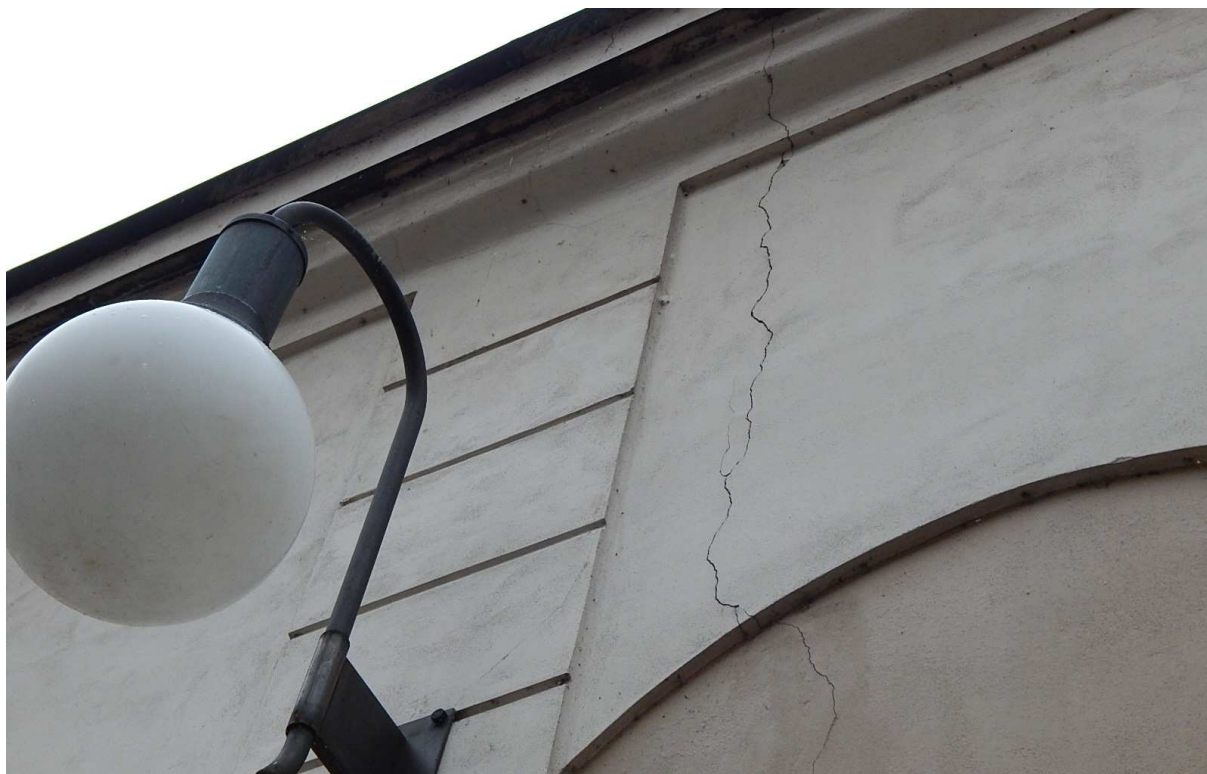
Trhlina v obvodovém zdivu vzniklá pravděpodobně v souvislosti s výstavbou vodovodní přípojky
