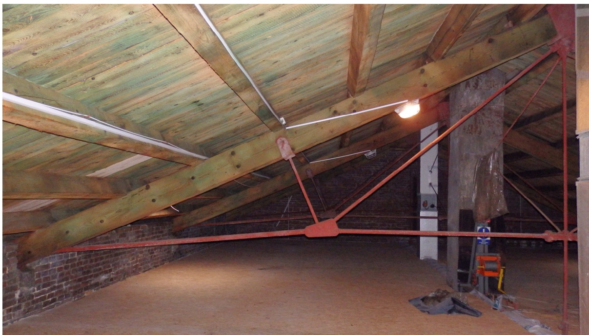
Konstrukce krovu vynášející strop nad hledištěm – stávající stav (srovnej s plánem z roku 1901 na str. 5)
