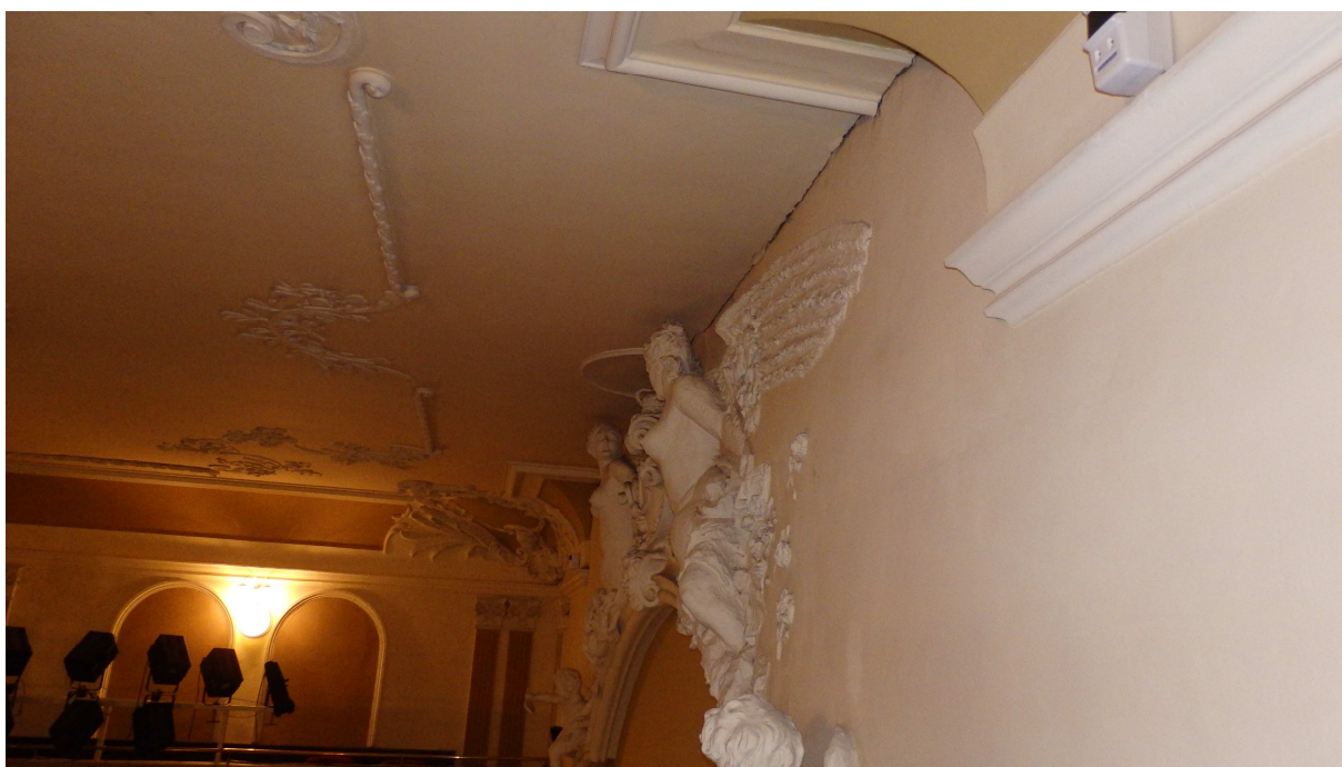
Trhlina na styku stropní konstrukce a svislé „čelní“ zdi sálu jeviště
