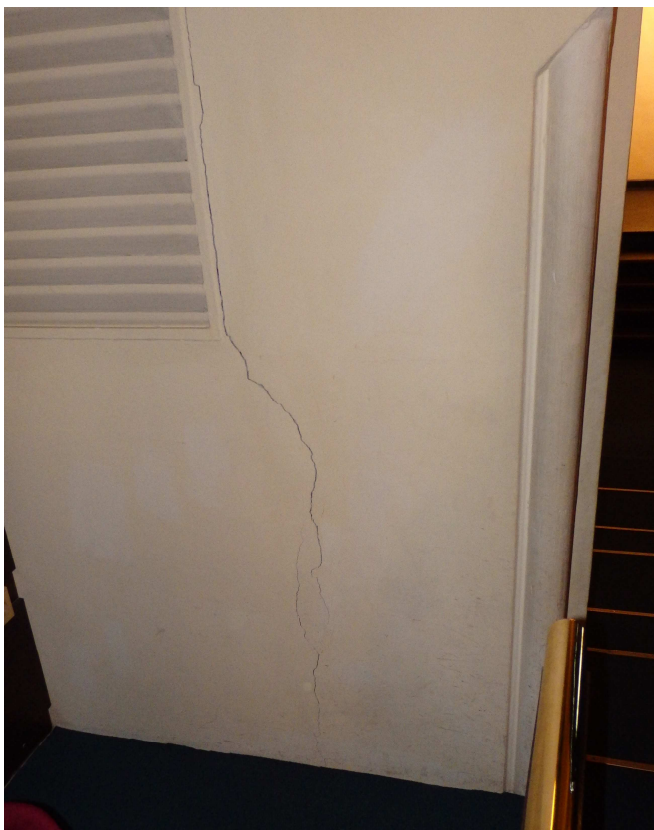
Trhliny ve zděných pilířích oslabených otvory pro technologii vytápění – rok 1962
