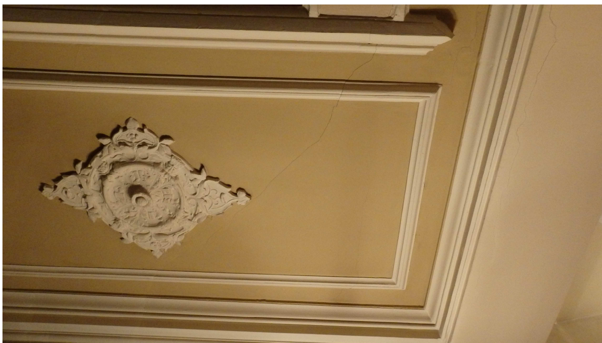
Trhliny v ploše podhledu stropu sálu jeviště, narušují i štukatérskou výzdobu
