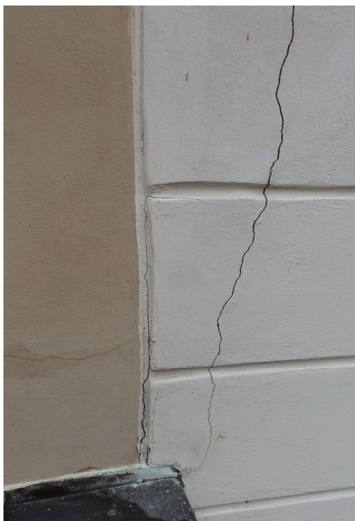
Trhlina „zděného kotvení“ přístavby k historické budově vzniklá v důsledku nerovnoměrného sedání přístavby
